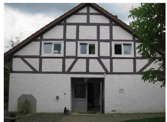
Nordfassade des Haupthauses
